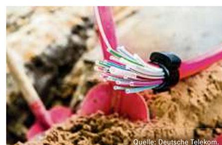
Für rund 3.300 Haushalte in Erkner baut die Telekom ihr Glasfasernetz aus.
